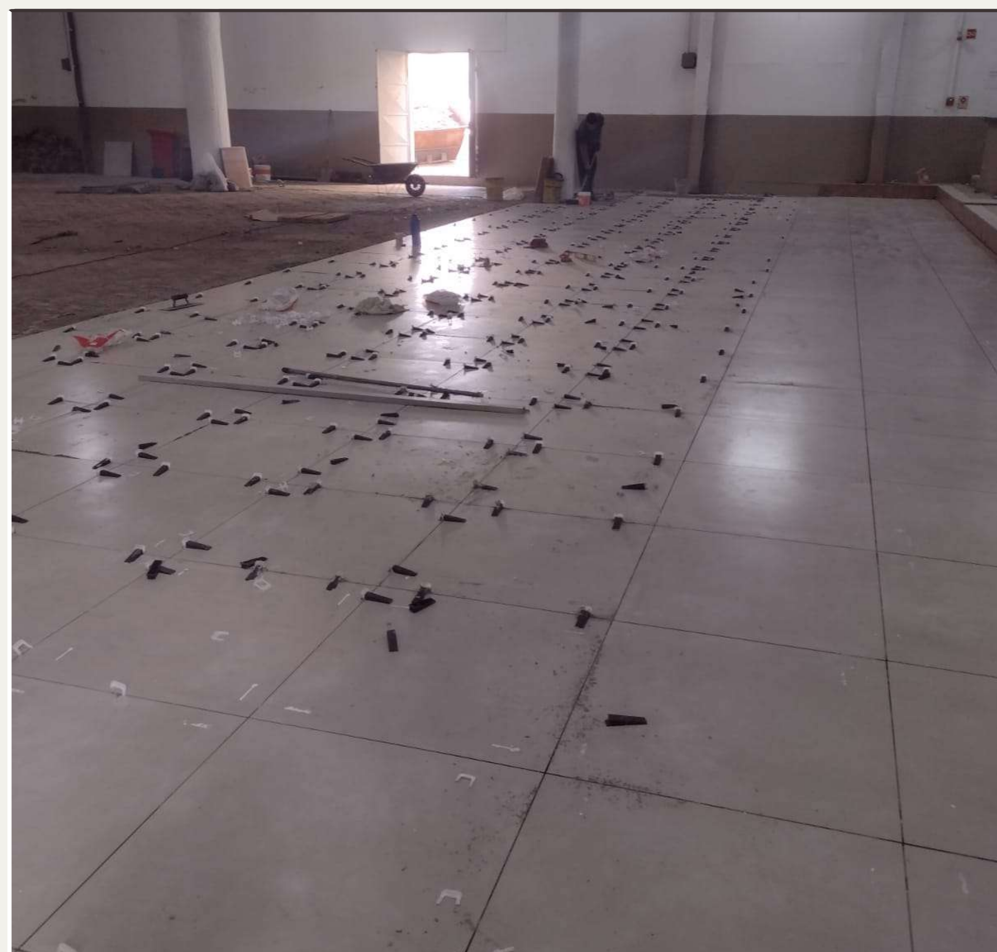
22/05 - Início da reforma do piso do Salão Paroquial
